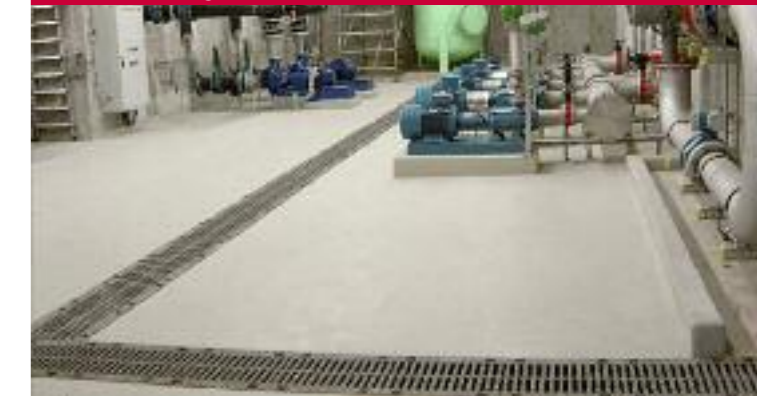
Flüssigkunststoff-Abdichtungen
